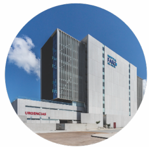
HOSPITAL EL FARO
